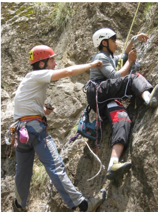
Sanierung alter Kletterrouten
